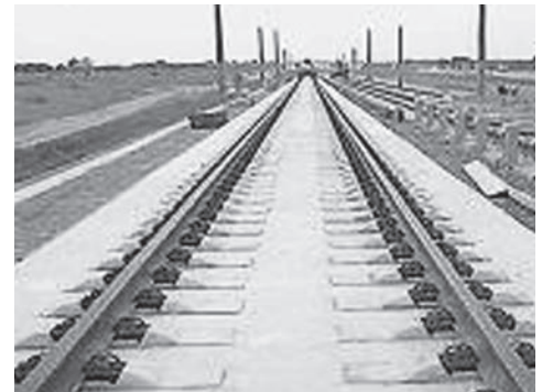
รูปที่ 17 ตัวอย่างทางวิ่งที่ไม่ใช้หินโรยทาง (ballastless track)
