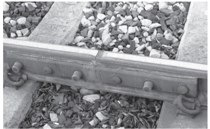
รูปที่ 9 รอยต่อของราง (rail joint)
