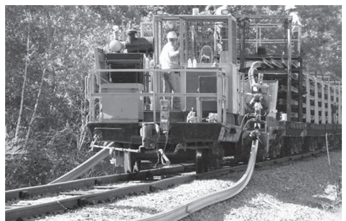
รูปที่ 10 การก่อสร้างรางแบบเชื่อมยาว (Continuous Welded Rail-CWR) [18]
